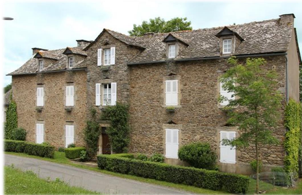
Bâti traditionnel à Trémouilles (patrimoine n°94)
