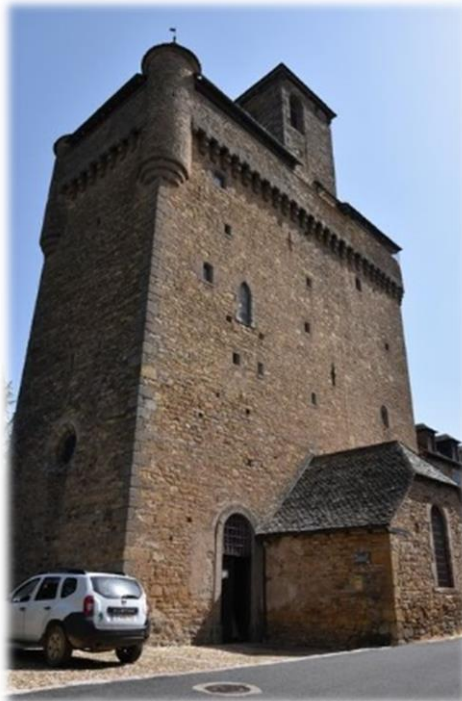
Église d'Inières (patrimoine n° 207)
