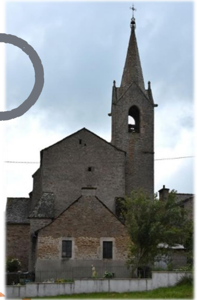
Église de Saint-Hilaire (patrimoine n° 279)
