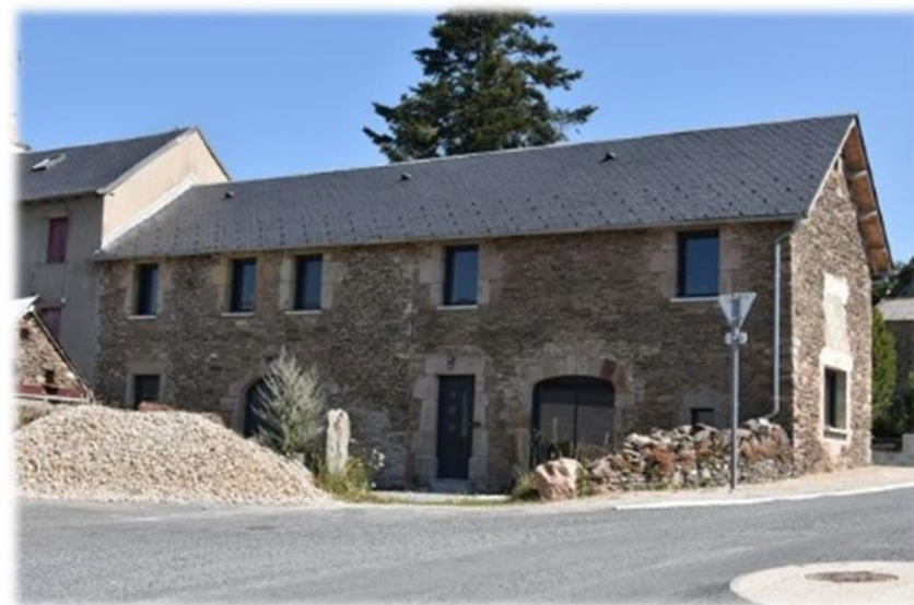
Grange réhabilitée au Vibal
