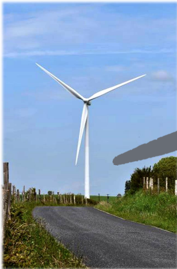
Éolienne à Salganset
