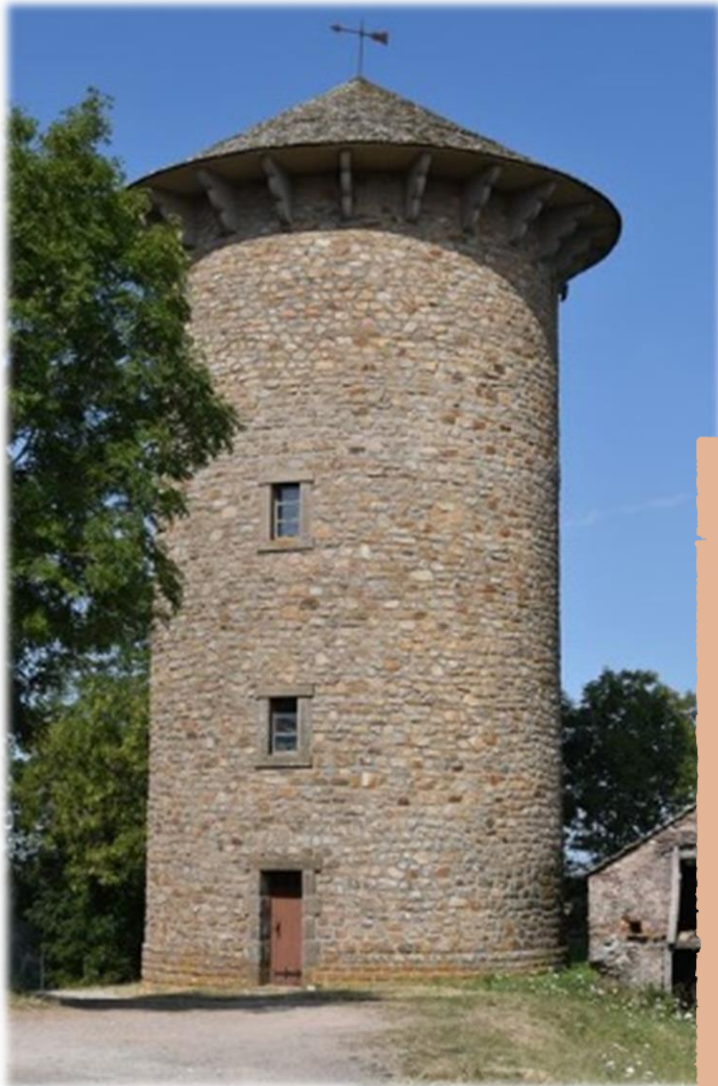
Château d'eau de Curan (patrimoine n°65)
