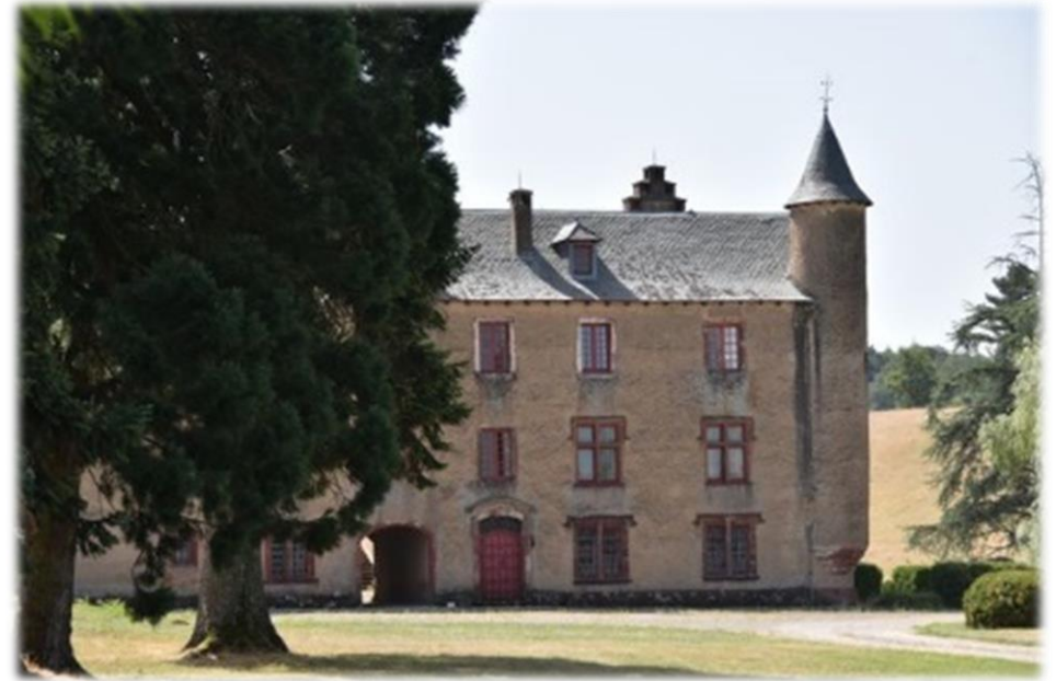
Château de Viel Veysac (patrimoine n°71)
