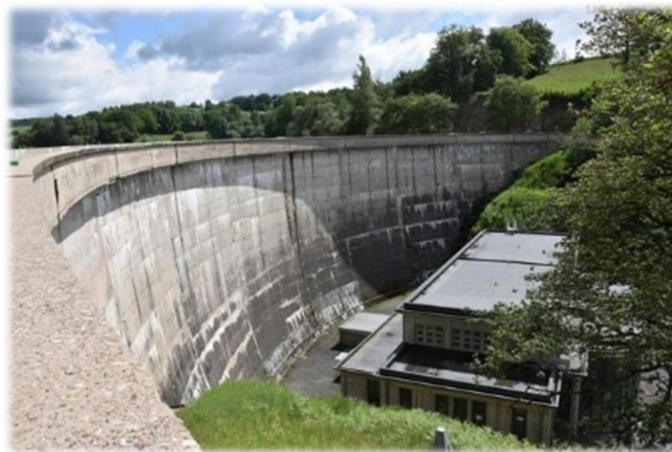
Barrage sur le lac de Bages
