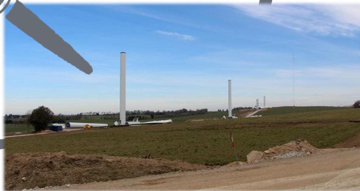
Montage des éoliennes de Flavin (22/03/2018)
